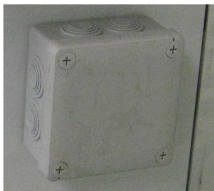
Rys. 11.24. Punkt pomiaru ciśnienia statycznego (wersja naścienna).
